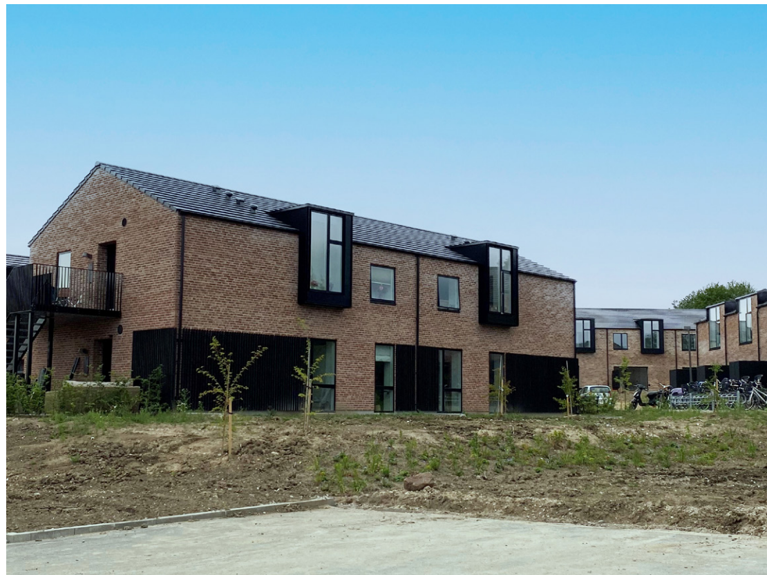
^ BOLIGBYGGERI TEGLSØERNE, NIVÅ
