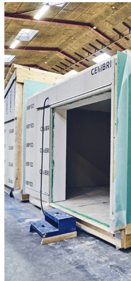
^ MODULE MANUFACTURING AT FACTORY IN LØGSTØR, SCANDI BYG
