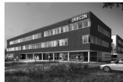
Construction of head office Orbicon Høje Tåstrup
